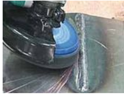
Entfernen von Verfärbungen
